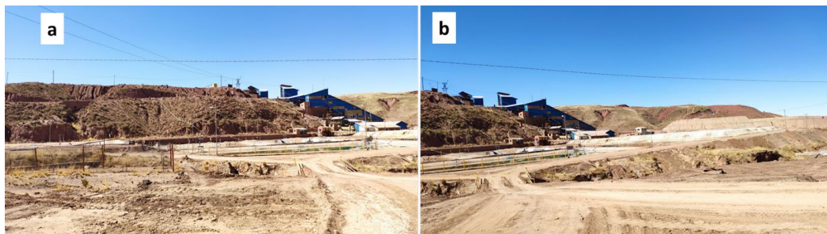
Figura 32 Labores y residuos mineros del complejo minero Coro Coro de la UH Alto Desaguadero, ingenio para el procesamiento de minerales (a) y dique de colas (b).
